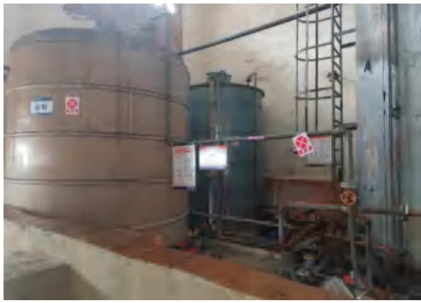
氧化二车间盐酸罐（已停用）
