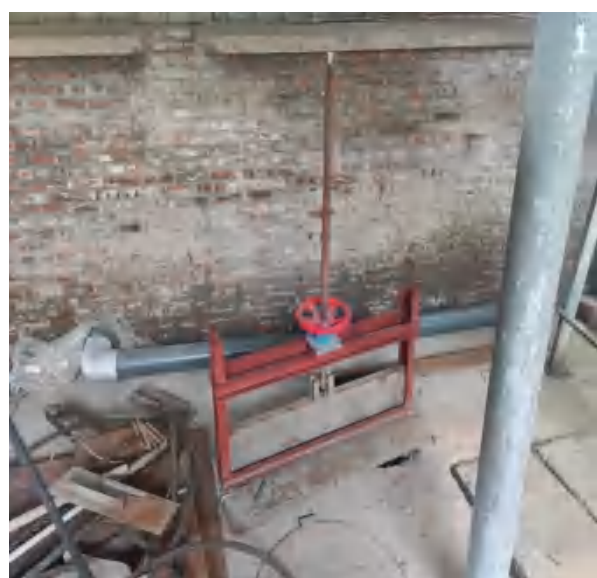
污水处理一站雨水口水闸
