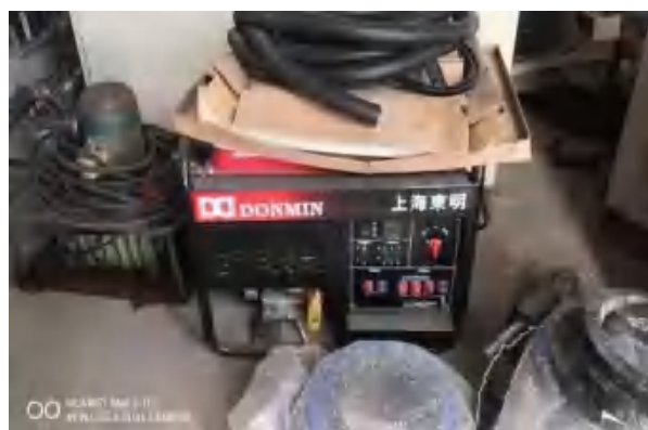
污水处理一站应急发电机
