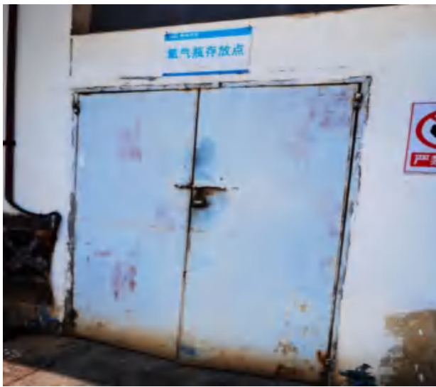
氧气瓶储存间
