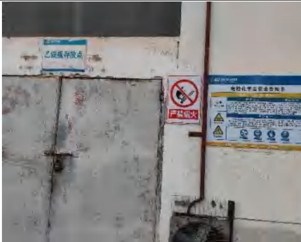
乙炔瓶储存间
