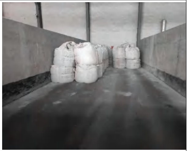
危险贮存库地面防渗工程
