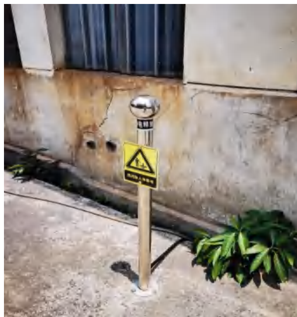
化工库外部静电释放器
