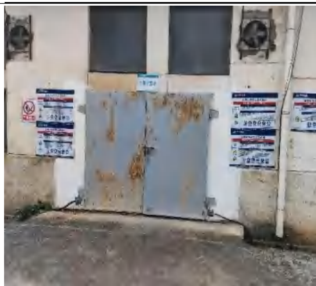
电泳漆储存间
